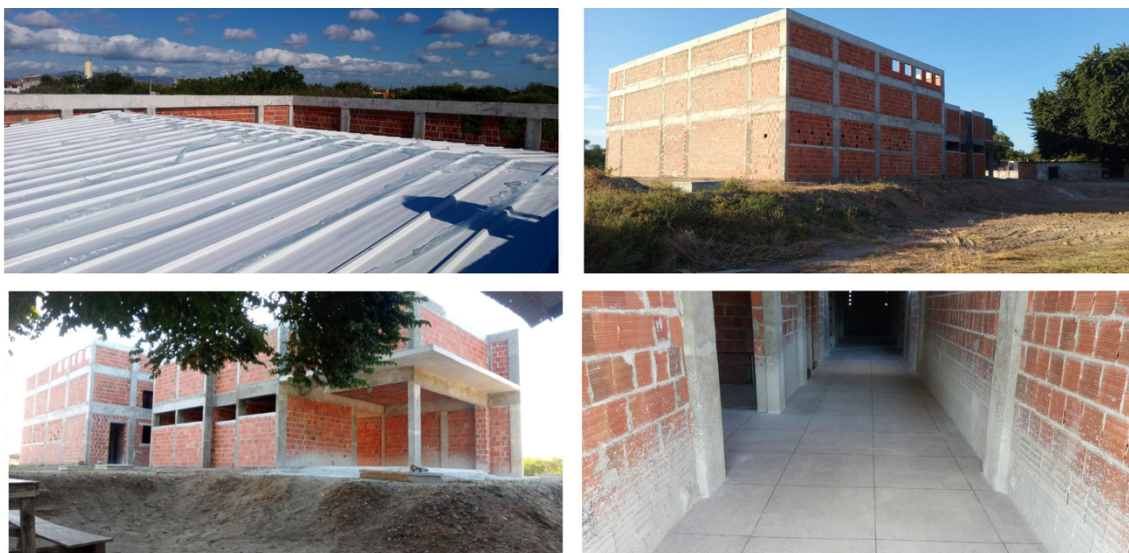
Figura 21. Execução da obra até Agosto 2021.
